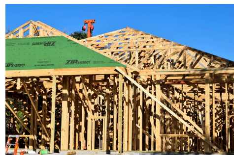
Ossature d'une maison en bois
